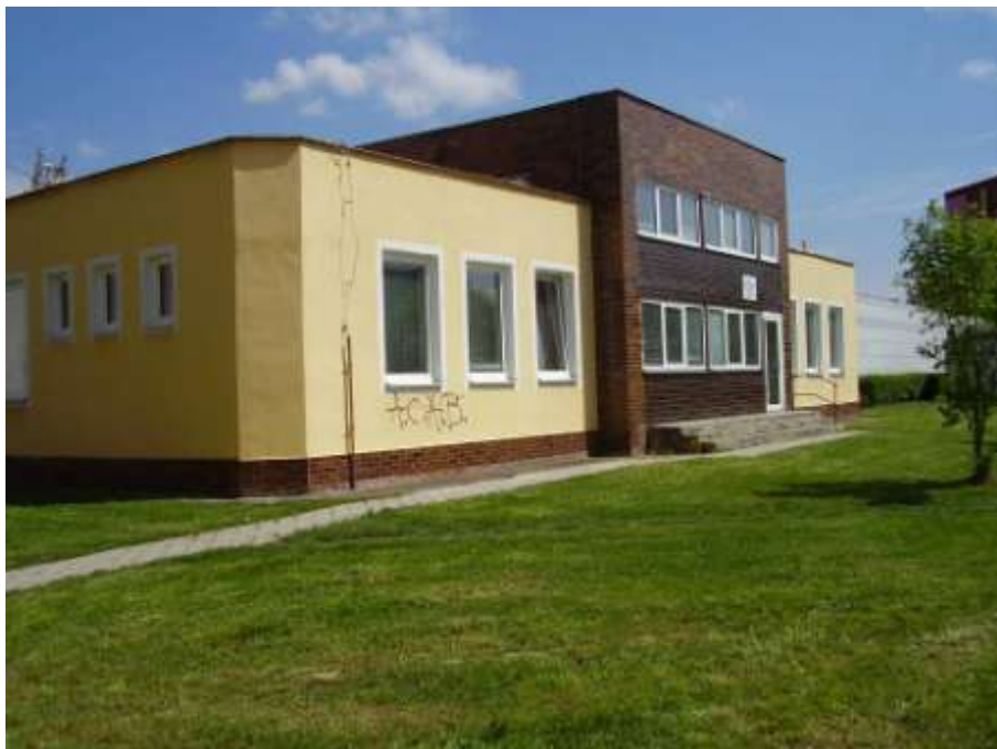
Pohľad na objekt DC1 zo strany prístupu na Riaditeľstvo OSS
