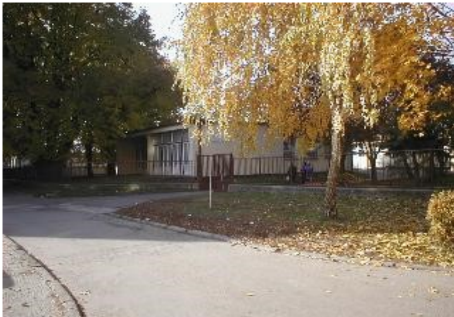
Objekt Domova sociálnych služieb pre deti a výdajné miesto jedálne.
