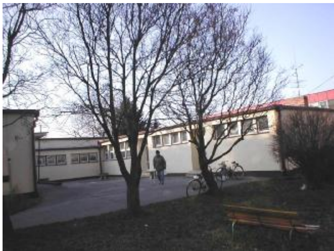
Objekt Domova sociálnych služieb pre deti a výdajné miesto jedálne.
