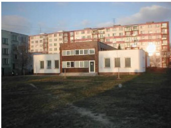
Pohľad na zadný trakt klubu dôchodcov č.1 – sídlo Správy OSS
