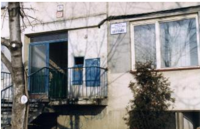
Vchod obytného domu na Jazernej ul., v ktorom je útulok
