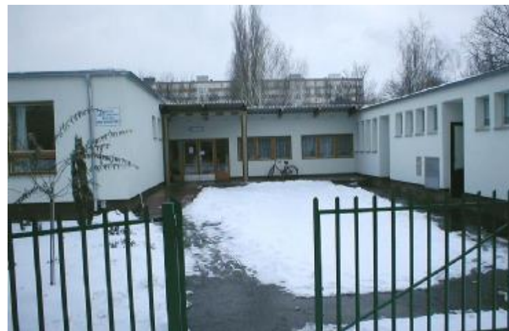
Nádvorie Domova dôchodcov Nádej a výdajné miesto Jedálne pre dôchodcov pri DD
