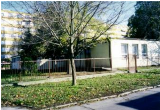
Objekt DSSPD na Okružnej ul.
